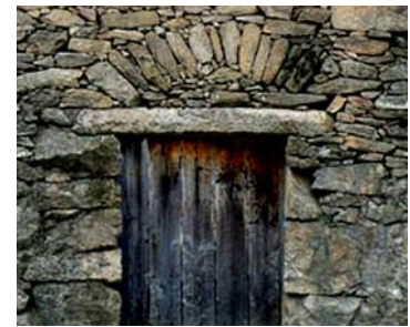
Puerta con dintel
