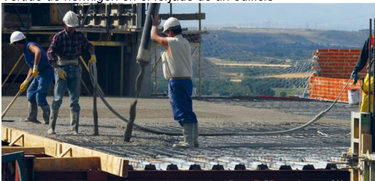
Vertido de hormigón en el forjado de un edificio
